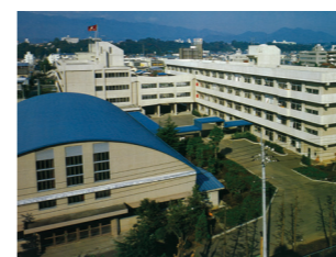
昭和37年 厚木市立中学校体育館
