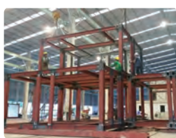
鉄骨フレーム 組み立て
