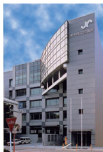
厚木商工会議所(栄町)の新会館の建設。
