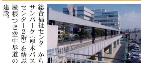
総合福祉センターからサンパーク(厚木バスセンター)2階を結ぶ屋根つき空中歩道の建設。
